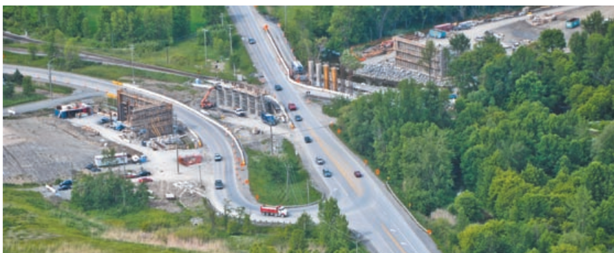
Bridge spanning rivière de la Tortue
