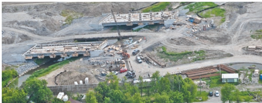
Bridge spanning rivière Saint-Pierre
